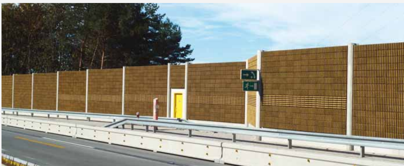
Steelring Třinec výška stěny 12,5 m lícová strana
