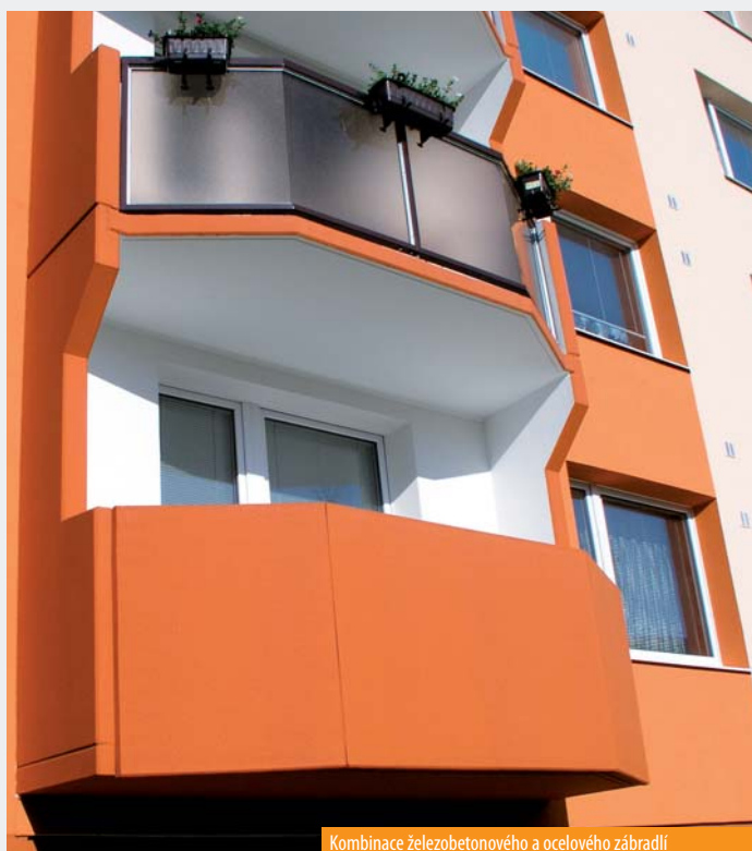
Kombinace železobetonového a ocelového zábradlí
