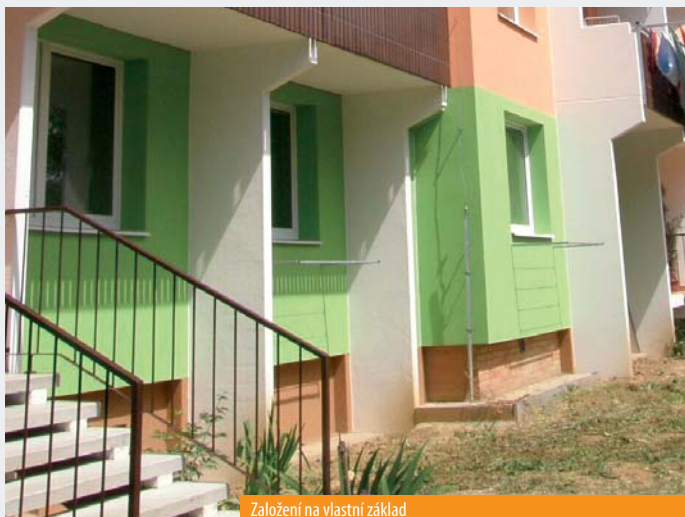
Založení na vlastní základ
