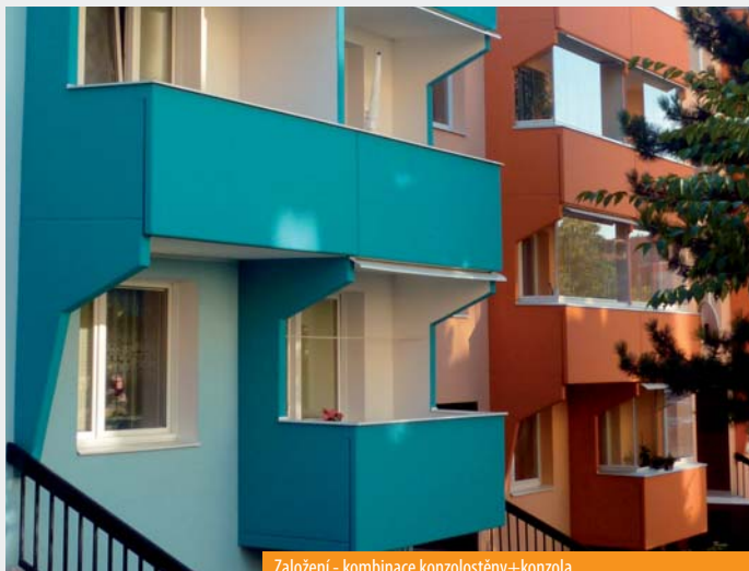
Založení - kombinace konzolostěny+konzola
