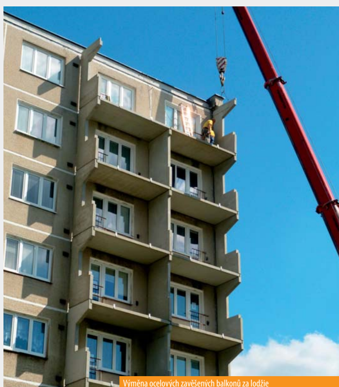
Výměna ocelových zavěšených balkonů za lodžie
