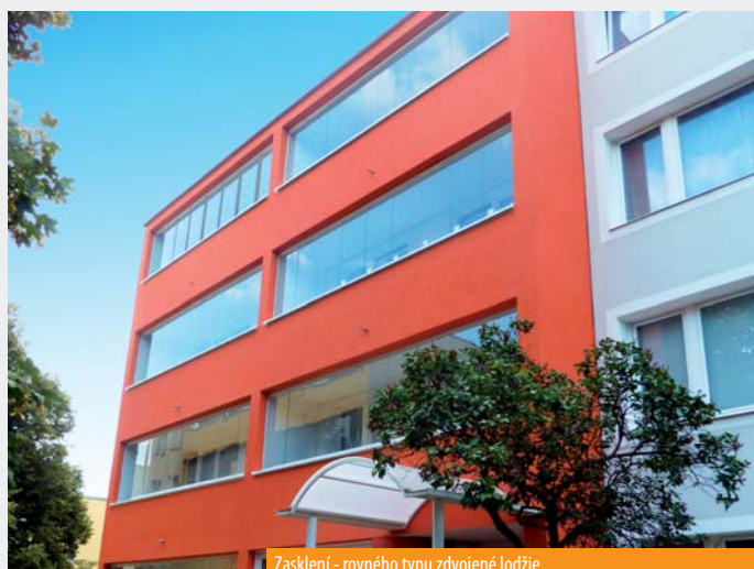
Zasklení - rovného typu zdvojené lodžie
