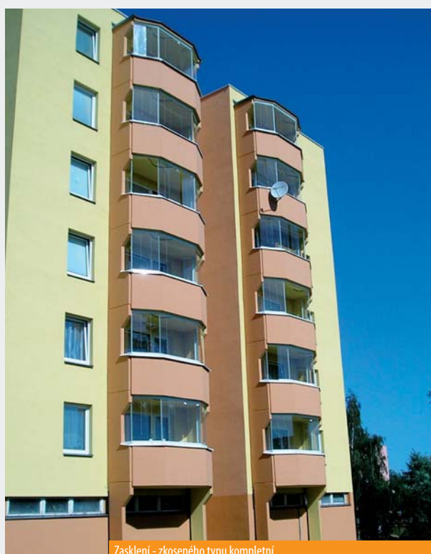
Zasklení - zkoseného typu kompletní
