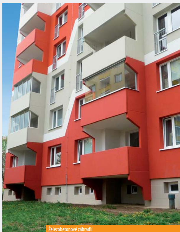
Železobetonové zábradlí
