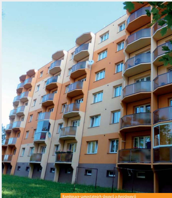
Kombinace samostatných sloupců a dvojsloupců
