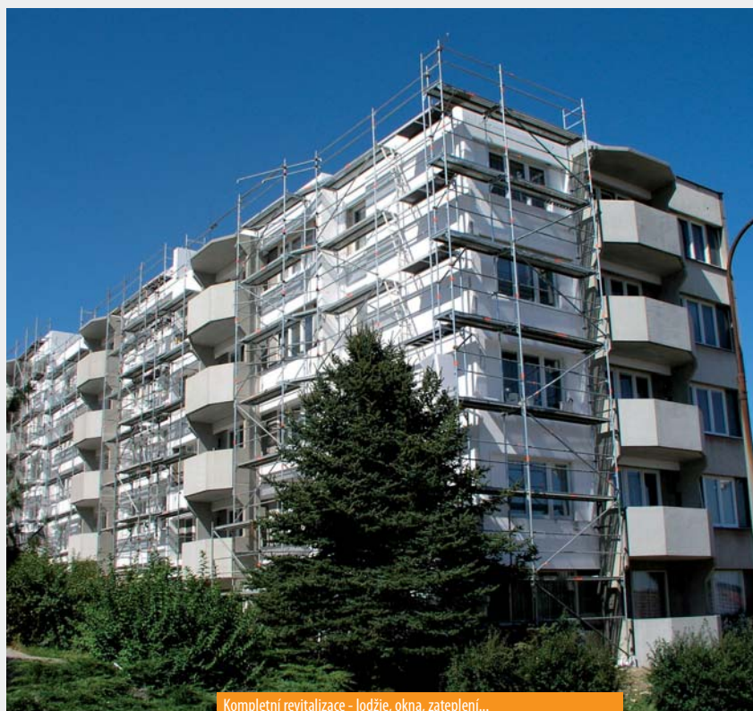
Kompletní revitalizace - lodžie, okna, zateplení...
