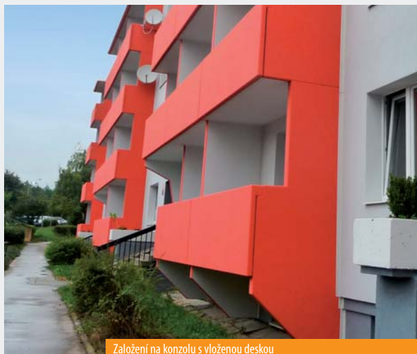
Založení na konzolu s vloženou deskou
