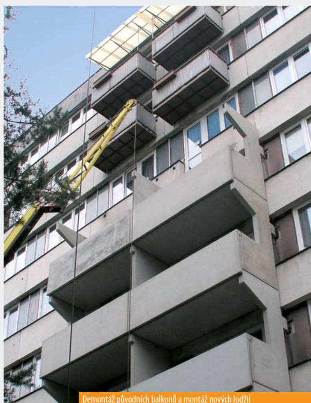
Demontáž původních balkonů a montáž nových lodžií
