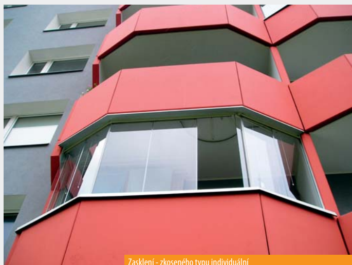
Zasklení - zkoseného typu individuální
